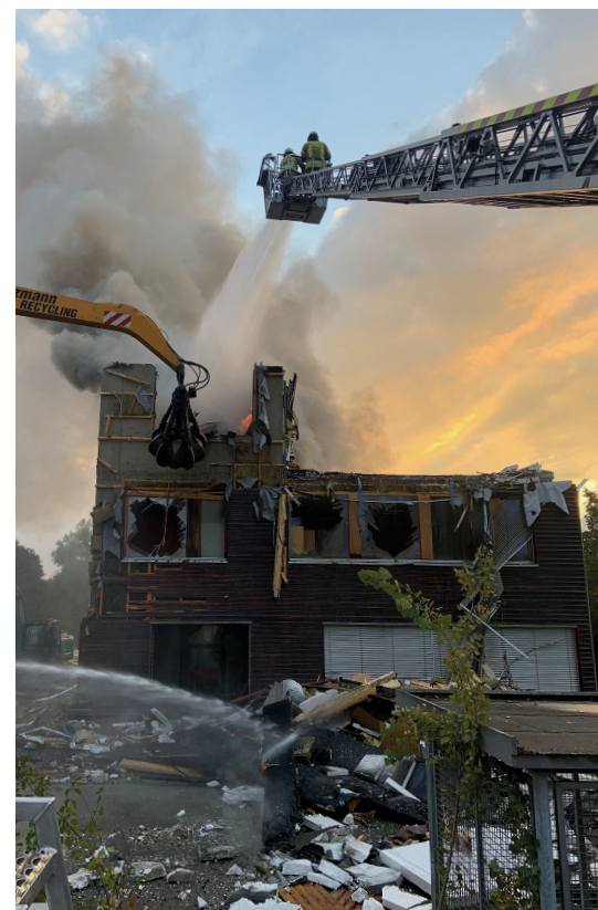
Durchzündung bei den Abbrucharbeiten
