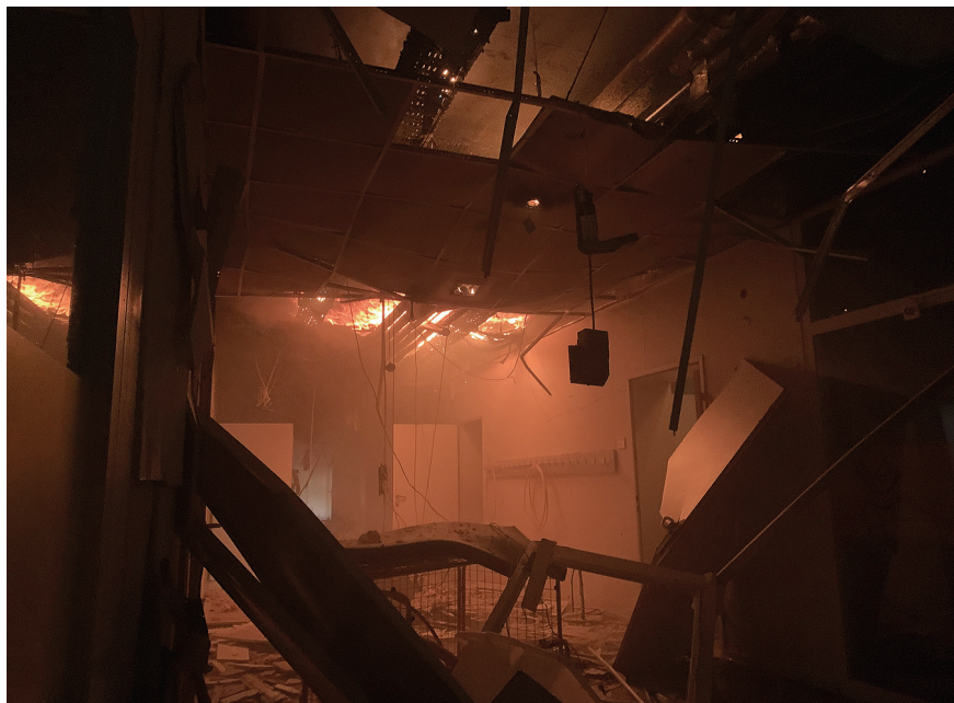
Blick in einen Treppenraum
