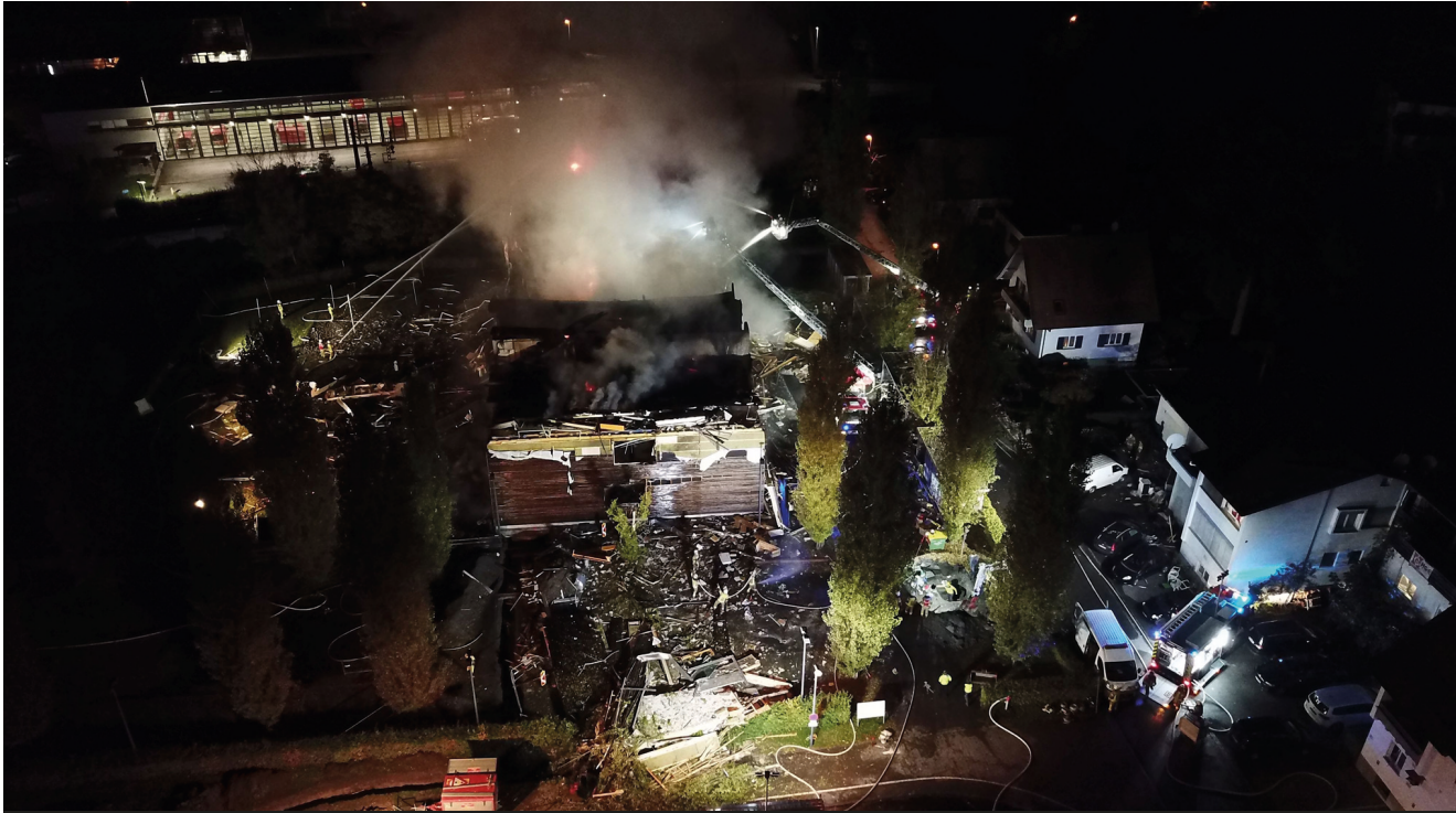
Die Drohnenaufnahme verdeutlicht das Ausmaß der Zerstörung (Ansicht von Osten). Im Hintergrund ist die Hauptfeuerwache Dornbirn zu sehen.
