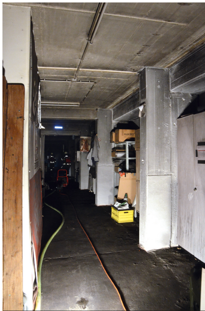
Das Bild zeigt die weiträumige Ausdehnung aus Richtung des zweiten Löschangriffs.
